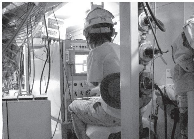
写真-10 左の箱が増粘材添加装置、排土監視により添加量を制御
