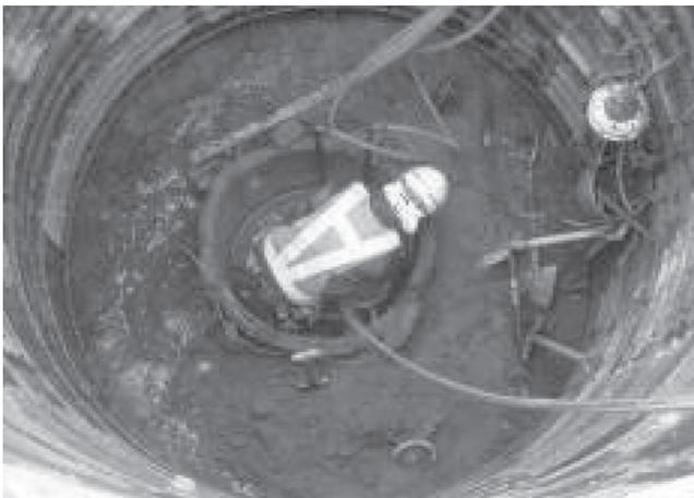
写真-11 既設人孔撤去、立坑築造
