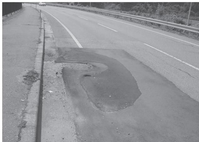
写真-2 人孔付近地盤沈下
