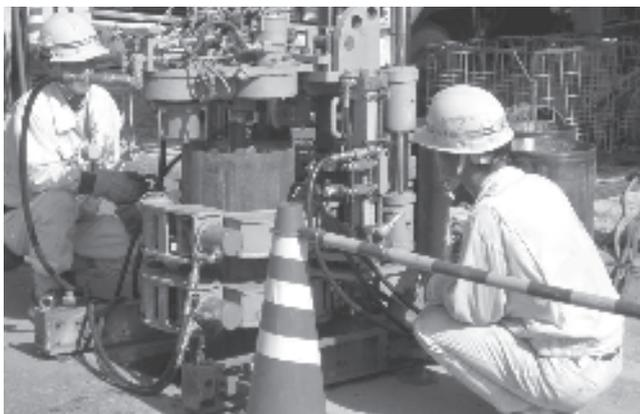
写真-1 ストライク工法機STM-1535 地上発進状況
