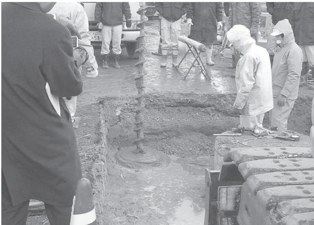
写真一七 ドリルオーガーでの補助掘削
