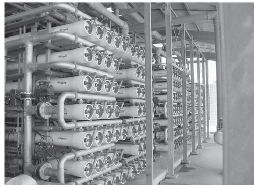
写真-11 RO膜ユニット (逆浸透膜)
