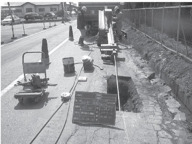
写真-4 パイロット削孔
