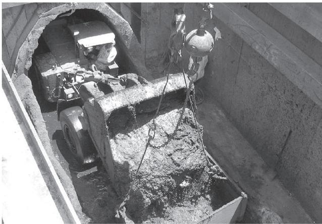
写真-3 管内土砂除去状況
