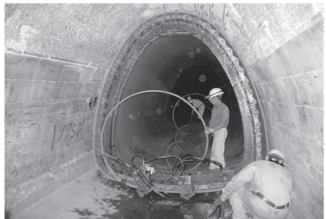
写真-2 既設管及び製管状況
