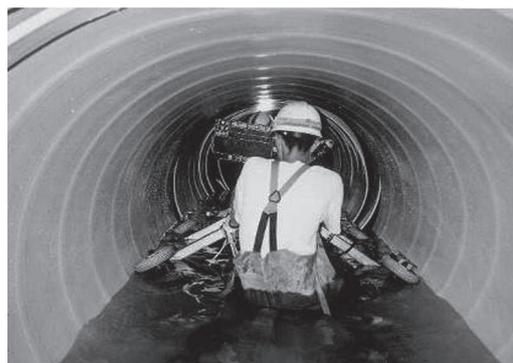
硬質塩ビの帯板をスパイラル状に巻きたてる更生工法である。帯板と既設管の空隙には2液混合型の充填材を注入する。基本的には複合管の考え方で減肉した既設管を更生することにより、耐荷力が増すことを実験で確認している。帯板と帯板を接合するための部材は伸縮性を持っており、地震時の伸びを期待している。円形、矩形、馬蹄形など種々の断面に対応可能であり、円形管では呼び径φ800～3000mmに適用。
