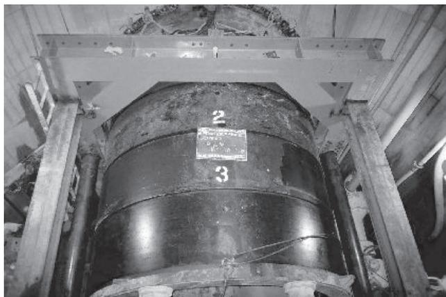
超長距離推進の代表選手、滑材の自動注入システムや専用滑材の開発で超長距離を可能にした。このほかセンプリングという発泡ポリスチレンのクッション板を管の上下に貼り付け、左右のカーブ時に接触面積を増やし管への応力集中を緩和する工法や曲線用特殊継ぎ手を併用することにより、急曲線推進も守備範囲となっている。また、今後も増加すると思われる大深度施工の上で問題となるバックギング（掘進機が先端閉塞され、水圧を受けることにより、発進坑での管の盛り替え時に管が発進坑側に飛び出してくる現象）を立坑内で管を締め付けて防ぐ方法なども紹介されている。どこまでをアルティミット工法と称するのか分らないところもあるが、このジャンルでの技術水準の高さを示唆する工法である。
