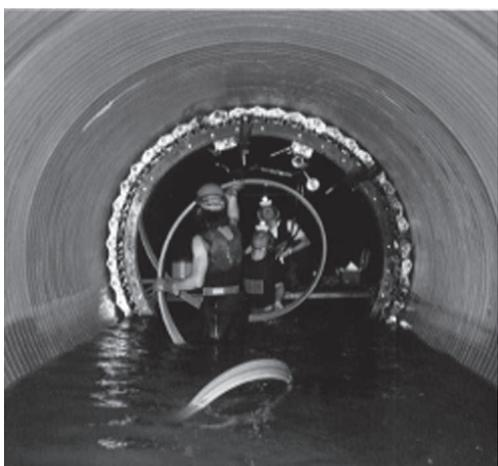
東京都での実績が豊富であることから中大口径管の更生工法では最も知名度が高い工法である。記事を読んで驚いたが、昭和61年の開発とのことである。約20年も前からあることになる。工法はプロファイルと呼ばれる塩ビ性の帯板を巻きたてる工法である。プロファイルは2重にロックする構造になっている。またスチール補強材をプロファイル外側に嵌めこむことにより剛性を高めるとともにスチールの塑性変形を利用してボックスなどの特殊形状を維持できるように工夫されている。プロファイルを巻きたてた後に裏面にモルタルを注入して既設管と一体化させると新管同等以上の強度に復元できる。円形、矩形、背割り管などの特殊断面の実績が多く、海外にも展開しているとのこと。
