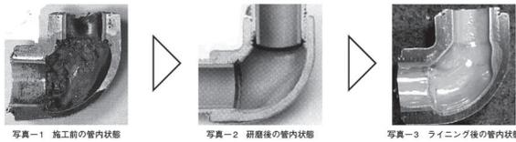
ガスで開発した技術を上水道に利用した工法。老朽管をブラスト処理した後に、エポキシ樹脂をピグを利用して塗りこむ工法である。ピグとはゴム製のボールで加圧空気により管内を移動する。15A～150Aに用いる。協会の分類には入らないが、防食塗装工法である。
