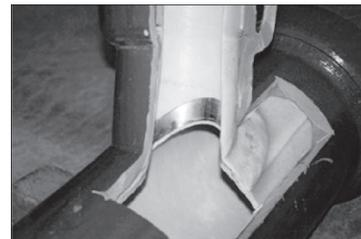
熱硬化型ライナー材を使用し、温水シャワーで固める。本管と取付管は反転工法、マンホールは形成工法といえる。 $\phi$  100～250 (取付管) および  $\phi$  200～800 (本管)、施工延長15m (取付管) および70m (本管)。自立管の反転工法に分類。
