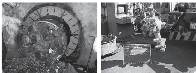
ヒューム管や外周を鋼板でおおって補強したヒューム管をマシン筒として用い、先端にカッターヘッドを取り付け掘進機として使用する。マシン筒の内部に組み込まれた駆動装置は分解して到達坑あるいは発進坑から回収できる工法である。したがって到達が既設人孔でも施工可能である。ヒューム管を掘進機の一部と
