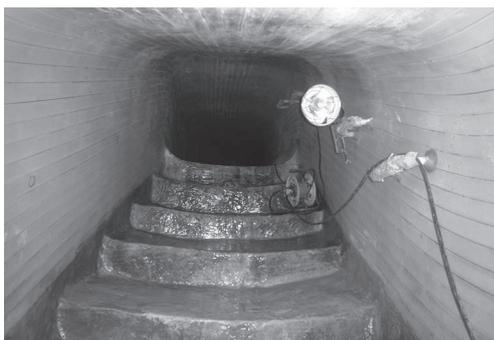
円形管ではφ800～3000mmの中大口径管の更生を目的とした工法である。鋼製リング、ポリエチレン製かん合部材および表面部材を既設管内面に組立て、既設管との間隙に高流動モルタルを充填する方式を採用。①既設管の損傷度合いに応じて更生管の強度を変えることができる、②矩形や馬蹄形などあらゆる断面形状および曲線敷設に対応できる、③管路を供用しながら更生することができる、などの特長を持っている。
