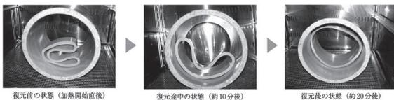
形状記憶塩ビを使用し、折りたたんで管内に挿入した後、蒸気で加熱して既設管内に密着させる。材質が塩ビであるので臭いや火災の危険がない。 $\phi$  150～200 (取付管) および  $\phi$  200～400 (本管) を標準とする。施工延長は50m ( $\phi$  350～400) および100m ( $\phi$  200～300) を標準とする。自立強度を有している自立管の形成工法に分類される。
