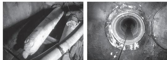
下水道用に開発された技術を電力用管更生に応用した工法である。内径150～1500mmに対応し、ライナー厚さは4mm以上である。熱硬化型ライナーを用い温水で硬化させるタイプである。また、オールライナーで補修した既設のヒューム管内へステンレス製可とう電線管を3条一括引き入れた、管路二重化工法と呼ばれている工事を紹介。
