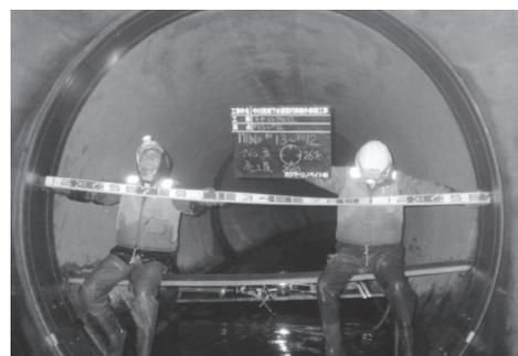
スナップロック工法とは主として小口径管の漏水箇所修繕に用いる工法である。裏面に水膨張ゴムを貼った幅数10cmのステンレスバンドを取り付けることで手軽に部分補修ができる。ここで紹介されているスーパースナップロック工法は中大口径管路用に開発したもので、ステンレスバンドは3分割部材となっており、マンホールから部材の搬入ができる。管内に搬入したバンドはくさび状の固定金具で組立てることにより内径3000ミリまでの管に対応した1体リングを形成可能である。マグマロック工法はスナップロック工法を応用した耐震補強を目的とした工法であり、管やマンホールの継手位置に装着することによりレベル2地震における抜け出しや屈曲に対応できる。
