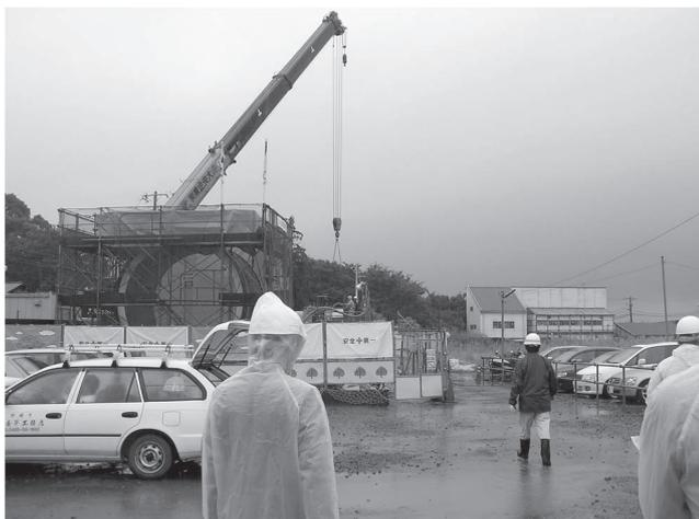
写真-6 現場用地が狭く、1台のクレーンで推進管と排土函をハンドリング（ここも雨）
