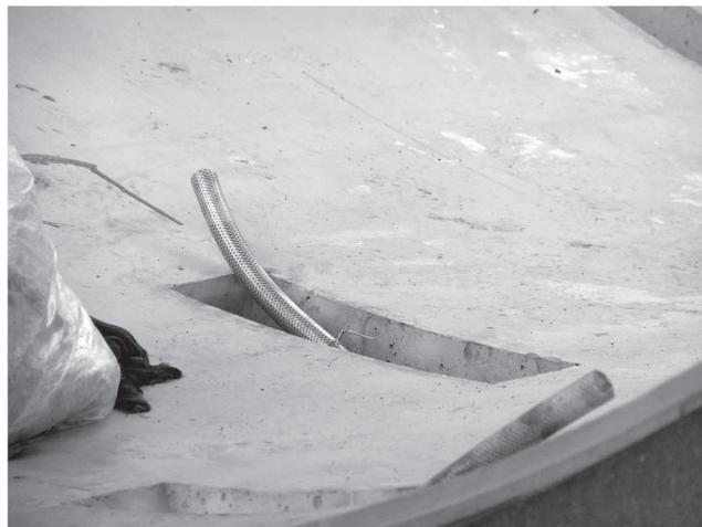
写真-5 PC鋼線用シース
