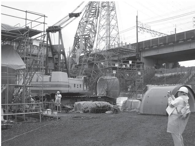
写真-4 推進管の仮置き状況（立坑用地が広い）
