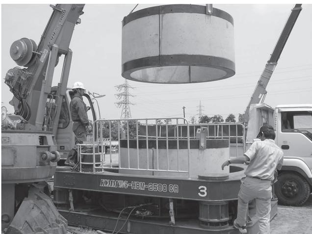
写真一四 コンクリートブロックの埋設状況
