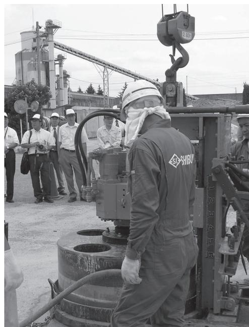
写真一五 マンホール上部改築工法 NSC工法
