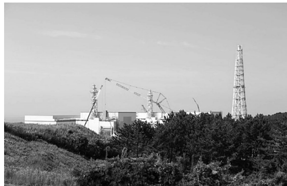
写真-5 5～7号機 (東京電力ホールディングス㈱Webサイトより)
