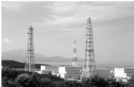
写真-4 1～4号機 (東京電力ホールディングス㈱Webサイトより)
