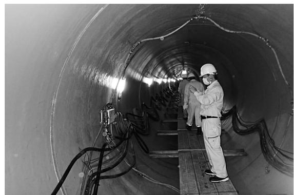
写真-6 多孔管の敷設状況
