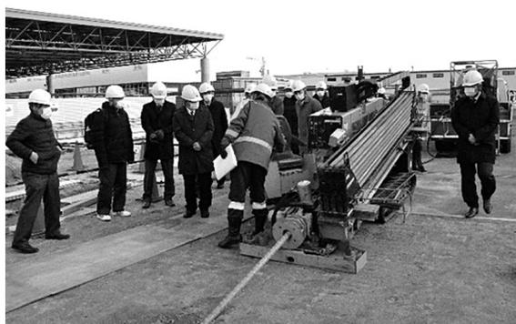
写真-7 HDD（誘導式水平ドリル）工法現地講習
