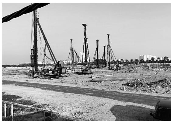
写真-8 ハンマー式杭打機
