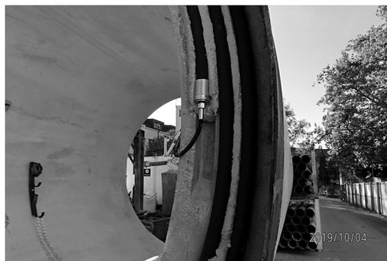
写真-6 The Hydraulic Joint 設置状況
