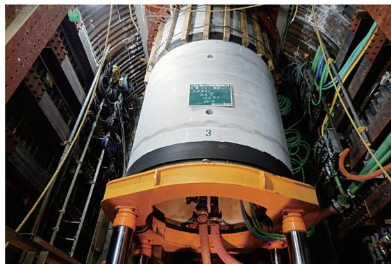
写真-1 鉄筋コンクリート管推進
