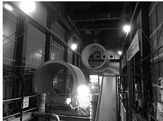
写真-2 防音ハウス 推進管移動
