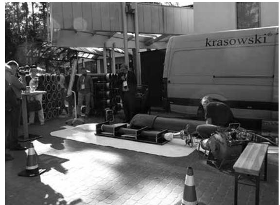
写真-4 屋外での管更生工法の実演 (LED硬化)
