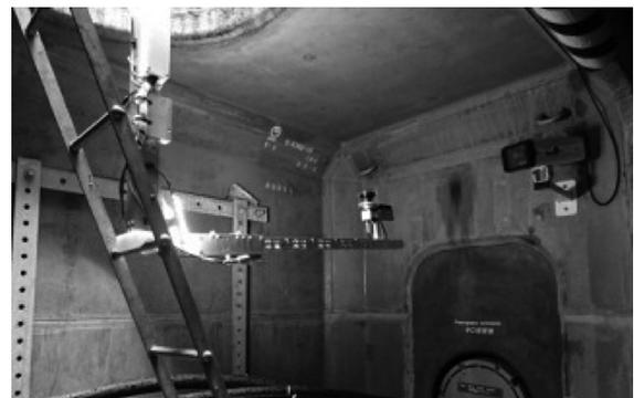
写真-3 未入孔装置のアームがマンホール内部を撮影する様子
