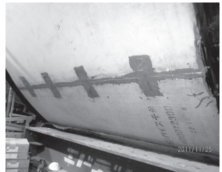
写真-7 推進管の接合状況
