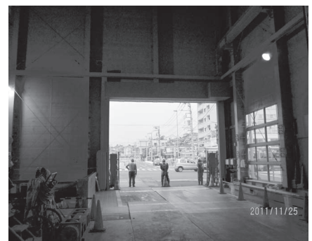
写真四 発進立坑内
