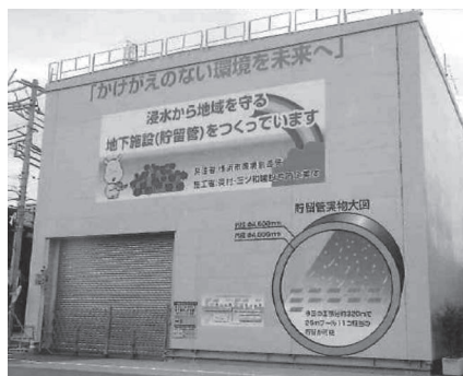
写真三 発進立坑囲障工
