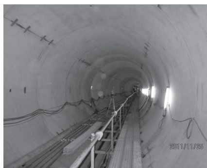
写真-9 推進管内
