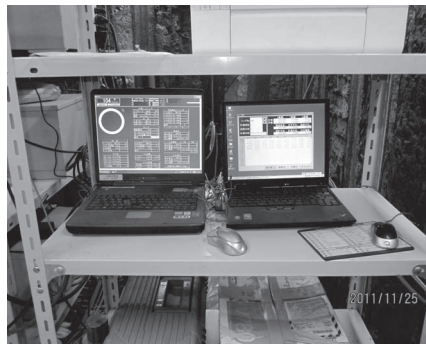
写真-6 推進管理状況
